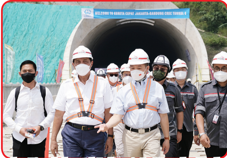
Dubes Tiongkok untuk Indonesia Lu Kang dan Menko Marves Luhut B Panjaitan meninjau lokasi pembangunan proyek Kereta Cepat Jakarta-Bandung.
